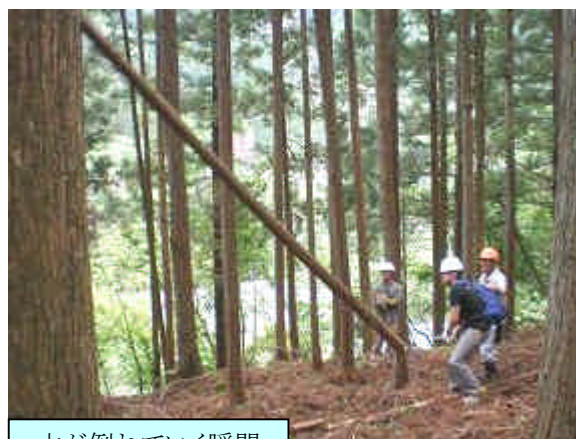
木が倒れていく瞬間
