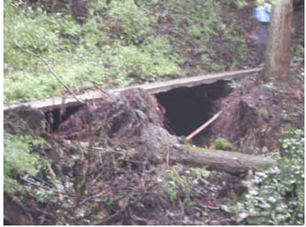
Bコースのアッチガオ沢の林道は崩壊、スギの巨木2本が倒れ、林道の下は空洞となった。
