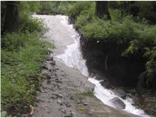
Bコースのアッチガオ沢の林道は崩壊、スギの巨木2本が倒れ、林道の下は空洞となった。
