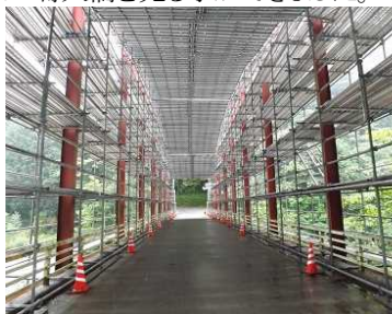
(塗装工事足場の寄大橋 9/18 松本)
